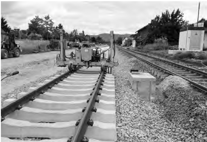
Errichtung des neuen Gleises am Bahnhof Littenweiler mit Hilfe einer sogenannten Gleishebe- und Richtmaschine
