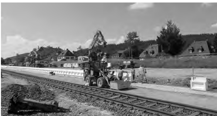
Aufbau der Bahnsteigkante am Bahnhof Littenweiler
