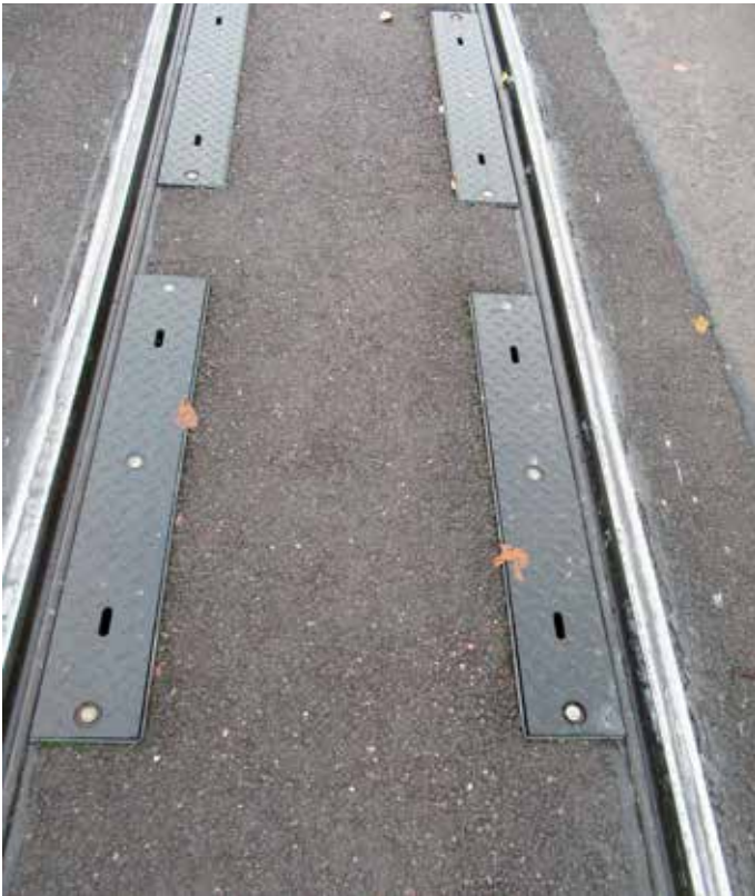
Stationäre Schmieranlage in der Lindenmattenstraße.
