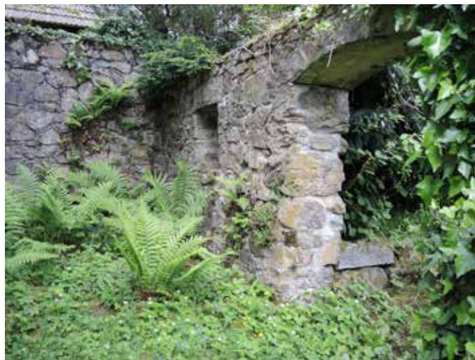
Die Ruine, Reste einer Ölmühle.
