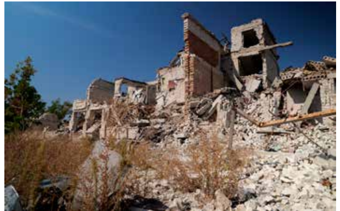
Komplett zerstört ist das Schulgebäude des Ortes.
