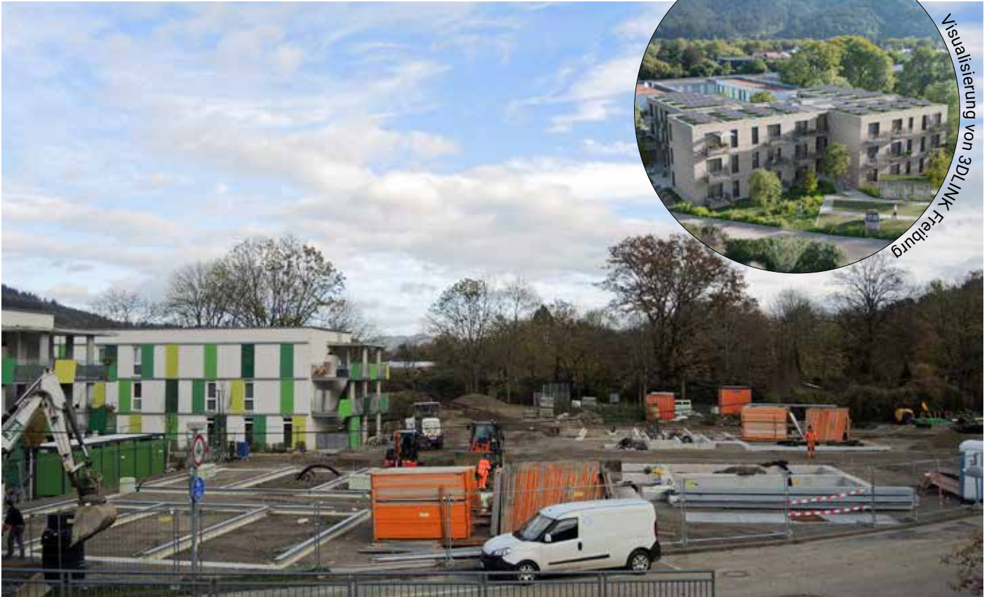
Die Bauarbeiten zum dritten Bauabschnitt gehen zügig voran.
