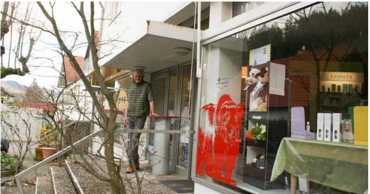
Derzeit noch Baustelle, aber Anfang Mai eröffnet Dagmar Ringe ihre neue Backstube neben der Bärenapotheke in Kappel. Auf dem Foto zu sehen ist Tom Ringe, Verkäufer an ihrem Stand auf dem Littenweiler Bauernmarkt, der sich mit ihr auf das neue Projekt freut.
