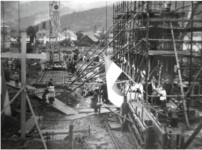
Unter der Fahne wird der Grundstein eingemauert – das Holzkreuz markiert den Standort des Altars.
