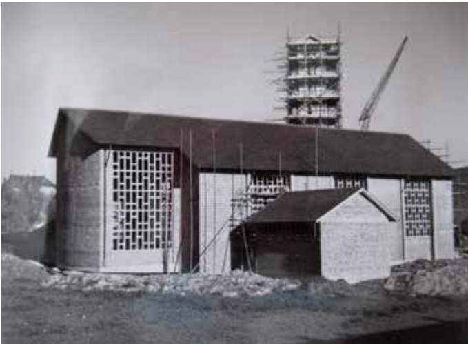
Kurz vor der Fertigstellung – ein Blick, der heute nicht mehr möglich ist. Foto: Karl Kurrus/Archiv Hans Loskant
